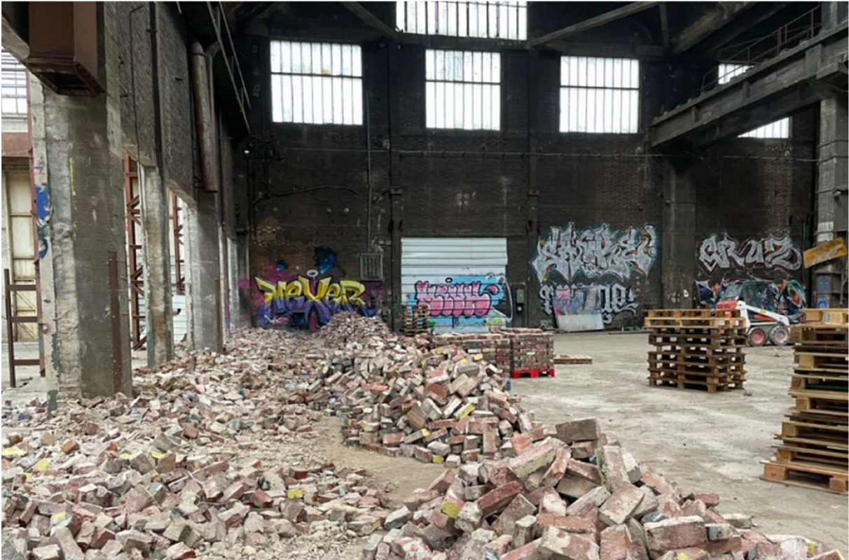
Briques déconstruites et entreposées avant tri et conditionnement. Crédit : Emerige
