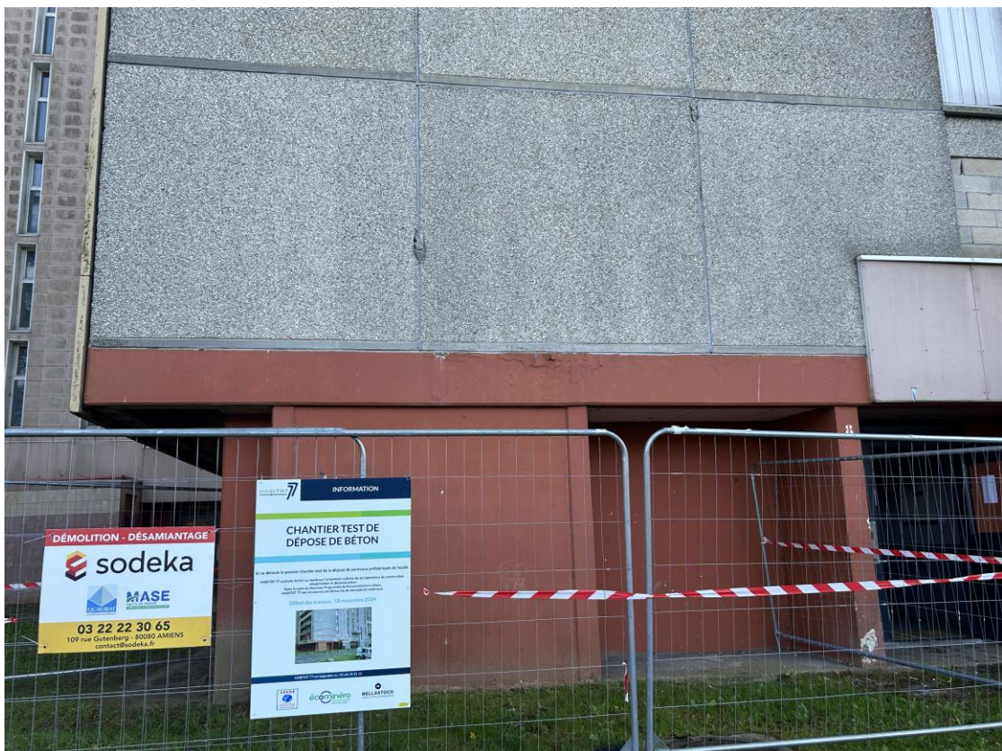
Chantier test - Crédit : Sodeka
