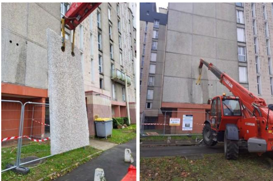
Dépose du panneau de façade - Crédit Sodeka
