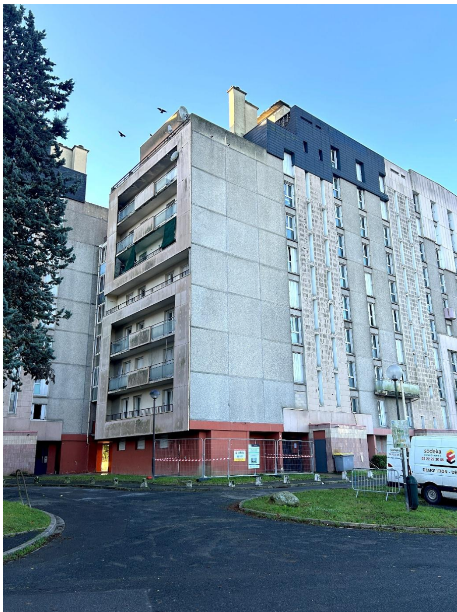
Résidence Chateaubriand à Melun, patrimoine du bailleur Habitat 77 - Crédit: Bellastock
