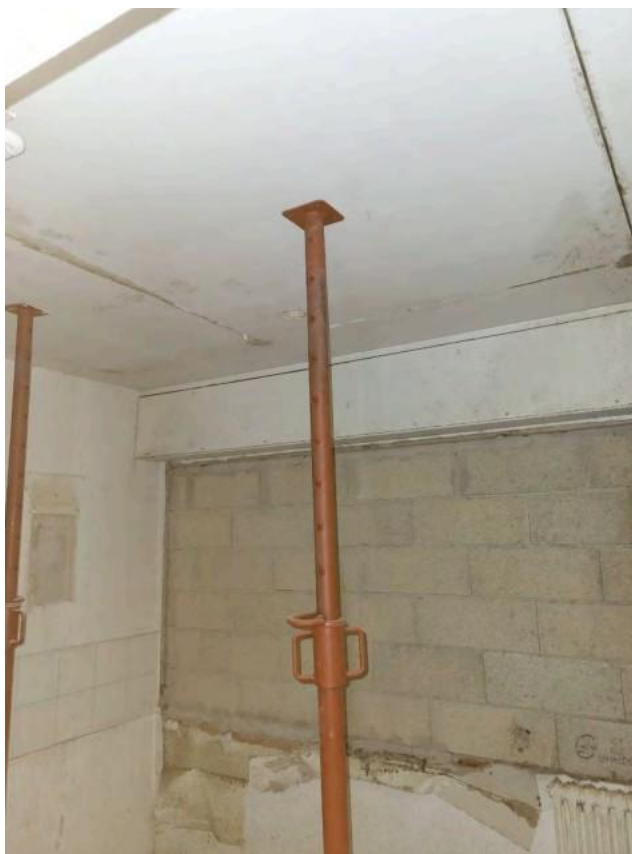
Etalement de la dalle de sol - - Crédit : Sodeka
