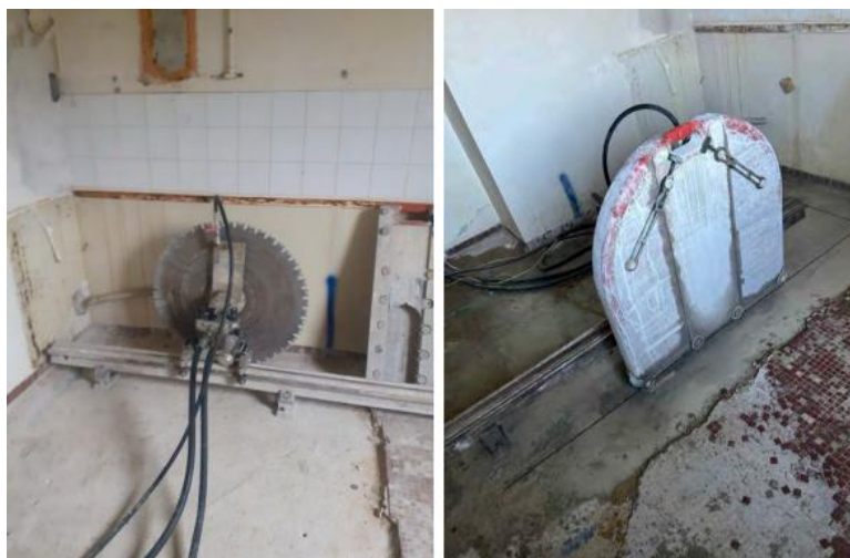
Sciage de la dalle de plancher- Crédit : Sodeka
