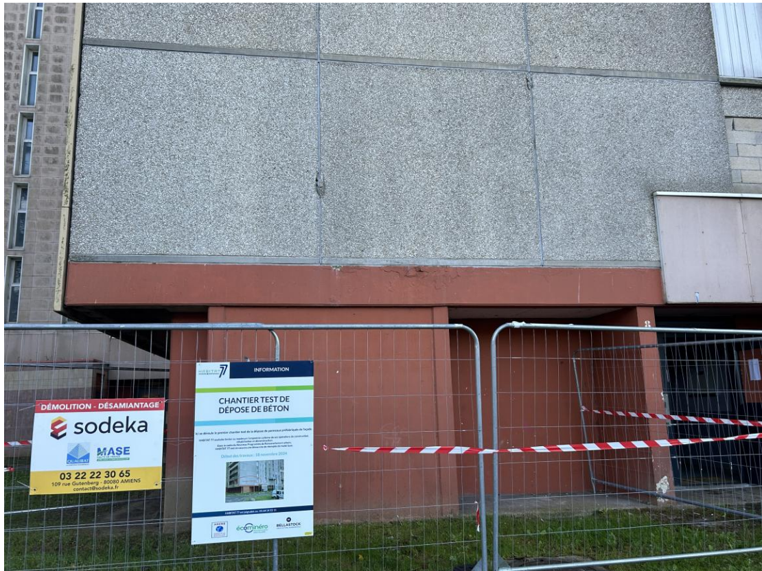
Chantier test - Crédit : Sodeka
