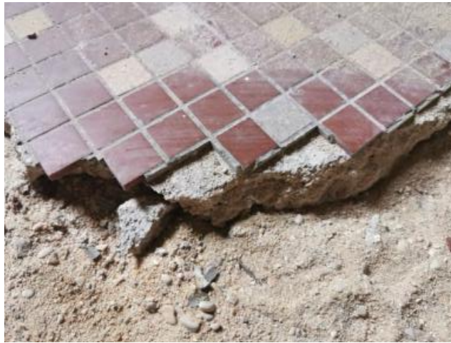
Dalle plancher avant curage - Crédit : Bellastock
