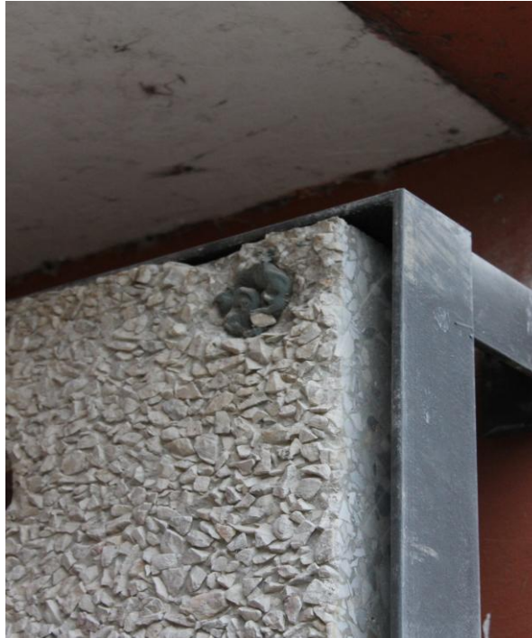
Zoom sur la fixation d'un prototypage d'un parement de façade - Crédit Bellastock
