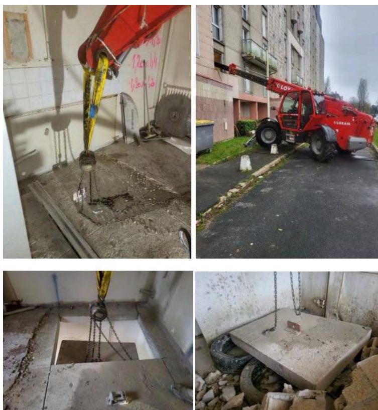
Dépose des dalles de plancher - Crédit : Sodeka
