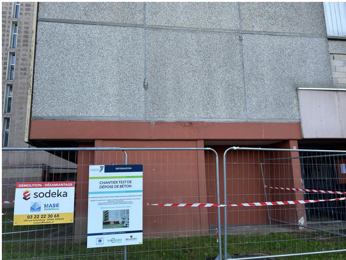
Chantier test - Crédit : Sodeka
