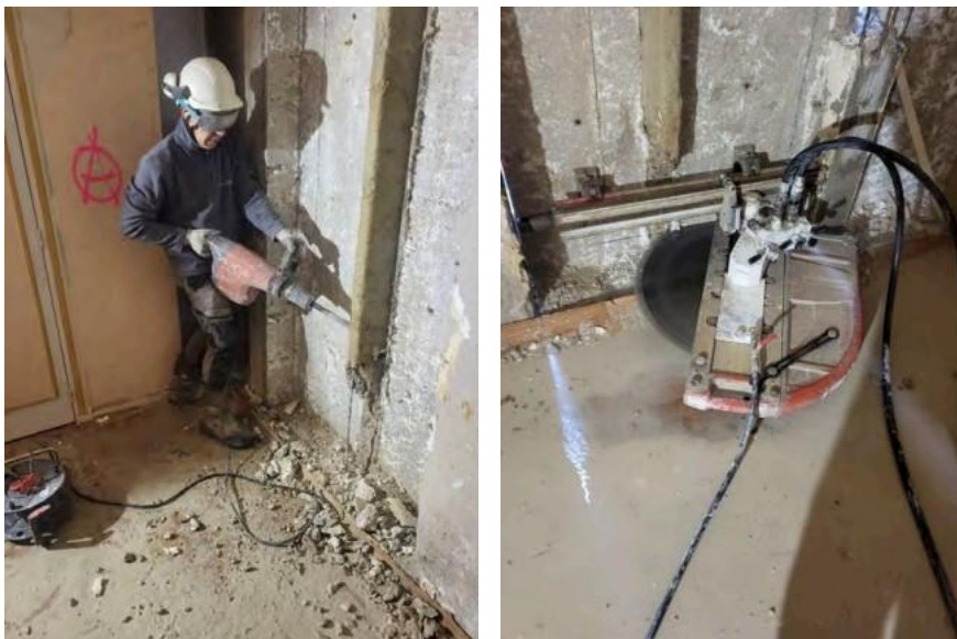
Piquetage des renfort et sciage du panneau - Crédit : Sodeka
