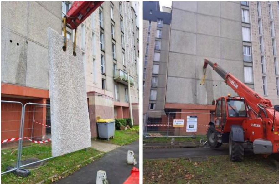
Dépose du panneau de façade - Crédit Sodeka
