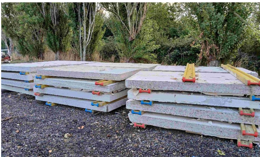
Stockage des voiles sur bastinges – Crédit : Matière Grise
