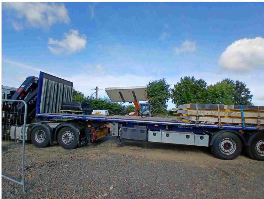
Chargement des voiles béton pour transfert sur site de la Picotière – Crédit : Matière Grise
