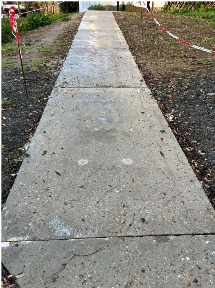
Murs de refends posés en cheminement piéton – crédit Ecominéro
