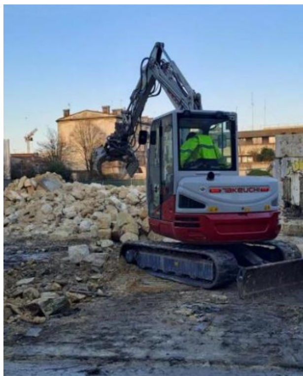
Tri à la pelle mécanique – Crédit : Domofrance
