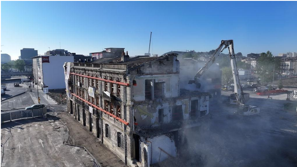
Déconstruction sur le chantier d'APSYS – Crédit : Domofrance
