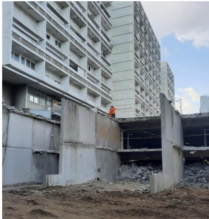
Dalles désolidarisées – Crédit : R-USE
