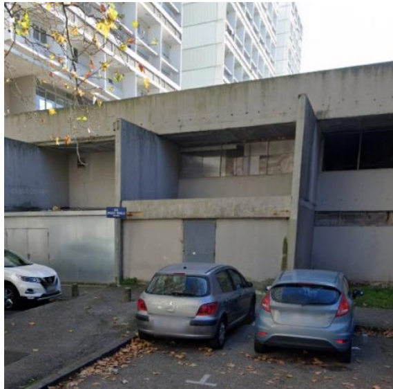
Dalle avec alcôves allant être déconstruites – Crédit : R-USE
