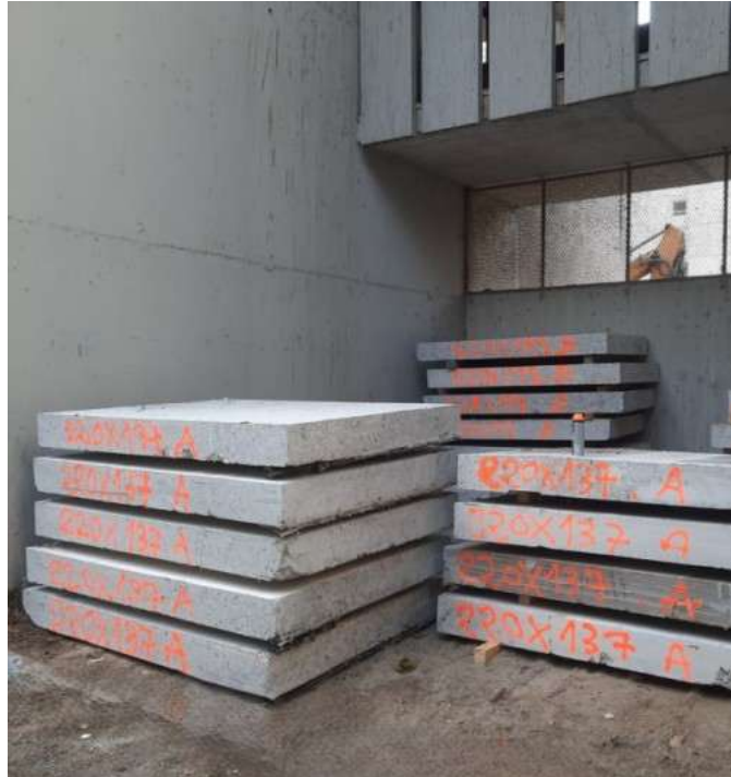
Stockage des dalles sur site – Crédit : R-USE
