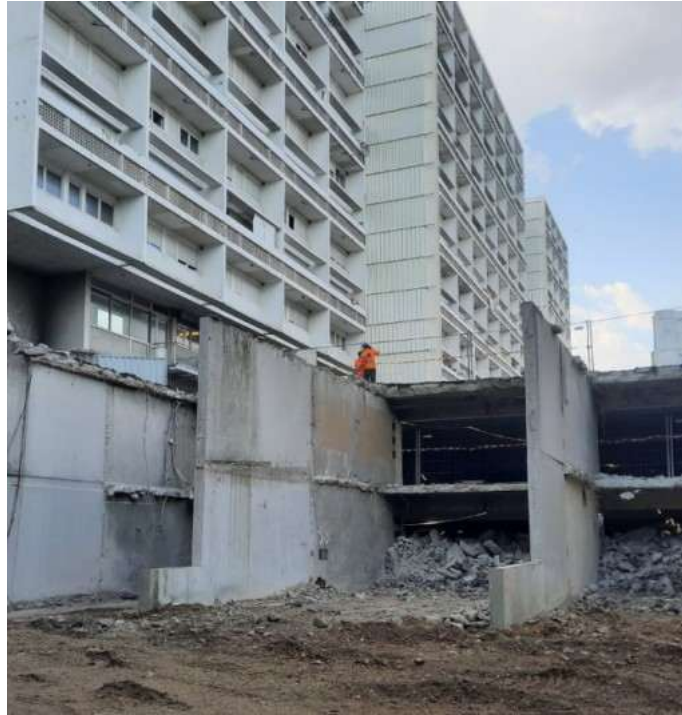
Dalles désolidarisées – Crédit : R-USE
