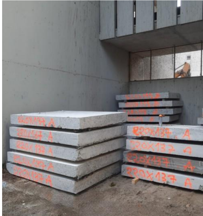
Stockage des dalles sur site – Crédit : R-USE
