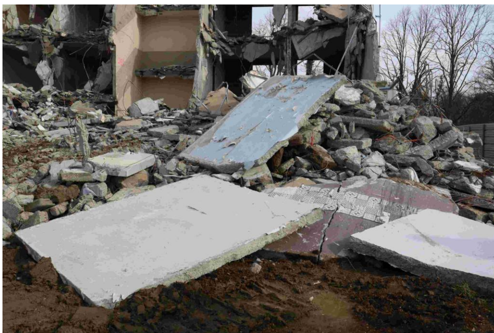
Dépose des voiles béton – Crédit : Collectif Cancan
