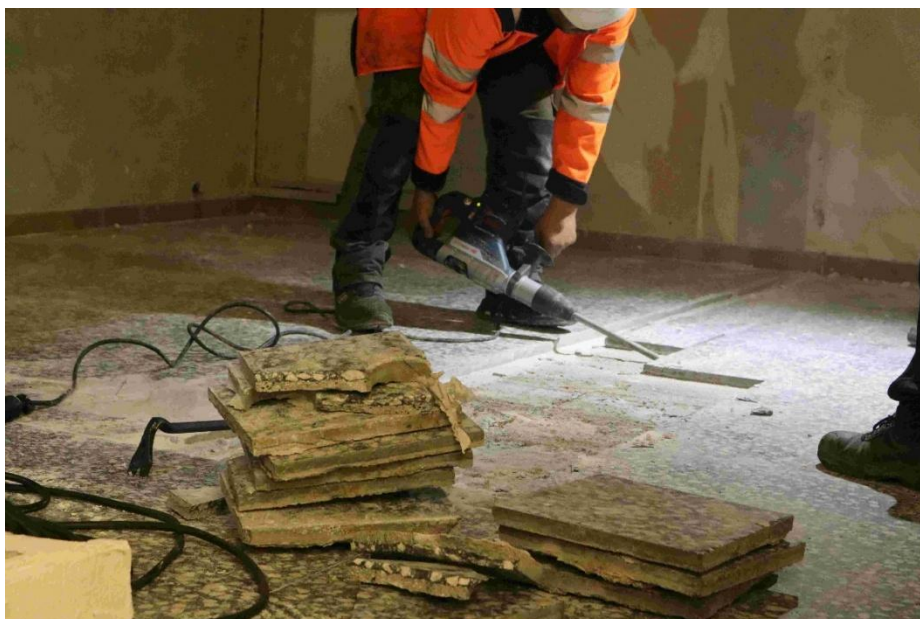
Dépose des carreaux terrazzo – Crédit : Collectif Cancan
