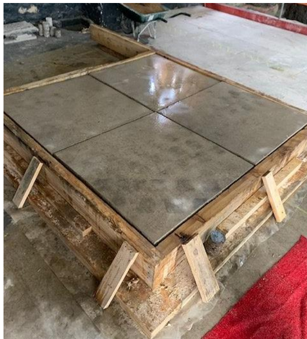
Prototype de repose réalisé au moment de la découpe – Crédit : Bouygues Construction
