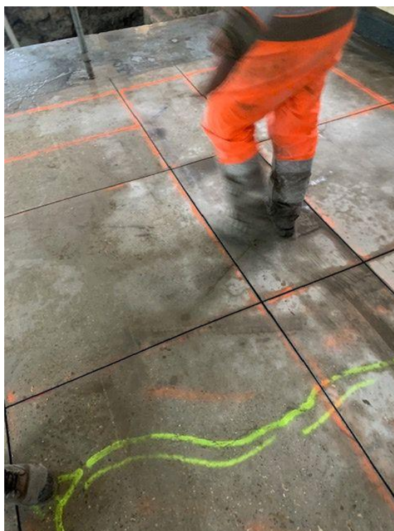
Traçage des dalles pour découpe – Crédit : Bouygues Construction
