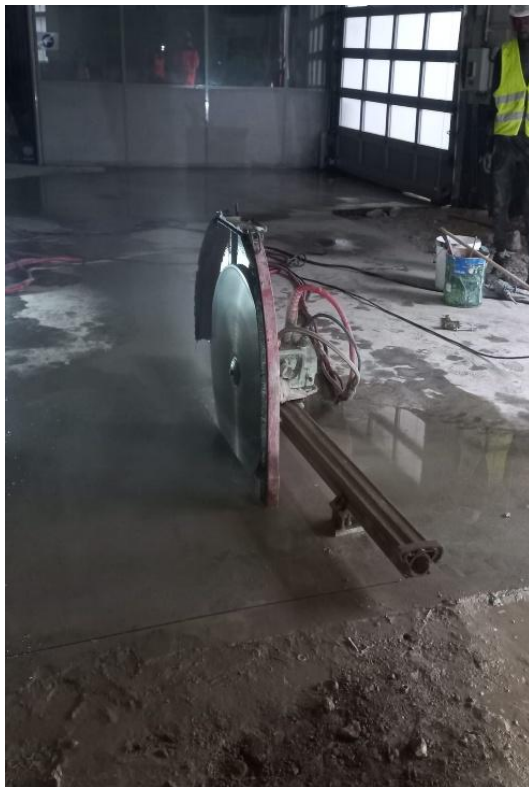
Méthode 1 : Test de sciage sur rail puis soulèvement à la fourche – Crédit : Bouygues Construction
