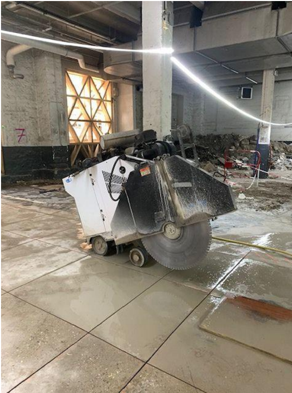
Méthode 2 : Test de sciage avec meuleuse et tracé manuel puis soulèvement à la ventouse – Crédit : Bouygues Construction
