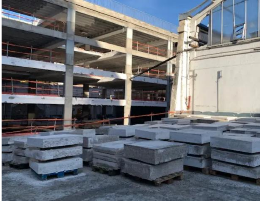
Stockage des dalles sur site avant envoi en entrepôt – Crédit : Bouygues Construction
