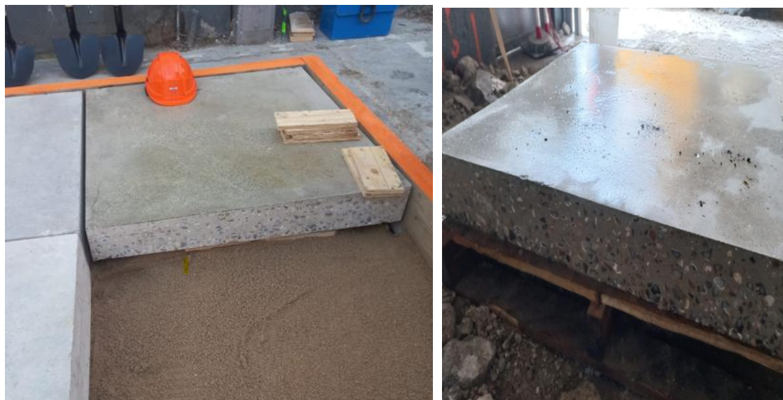
Prototype de repose réalisé au moment de la découpe – Crédit : Bouygues Construction
