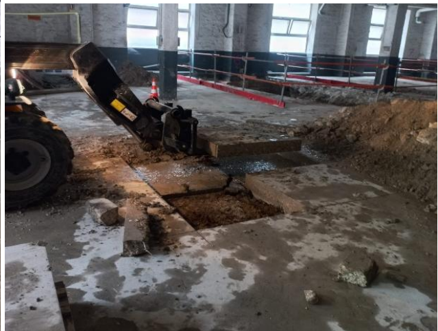
Méthode 1 : Test de sciage sur rail puis soulèvement à la fourche – Crédit : Bouygues Construction
