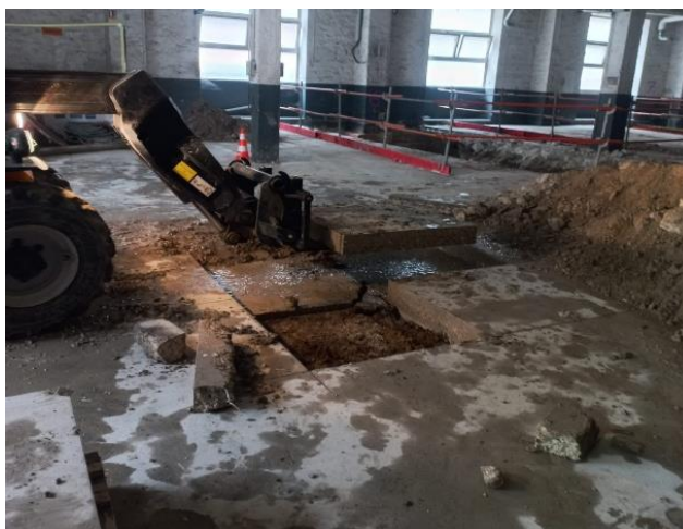
Méthode 1: Test de sciage sur rail puis soulèvement à la fourche – Crédit : Bouygues Construction
