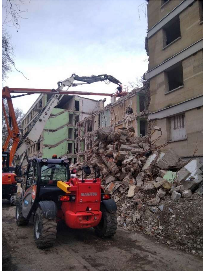
Déconstruction du bâtiment A – Crédit : Ecominéro
