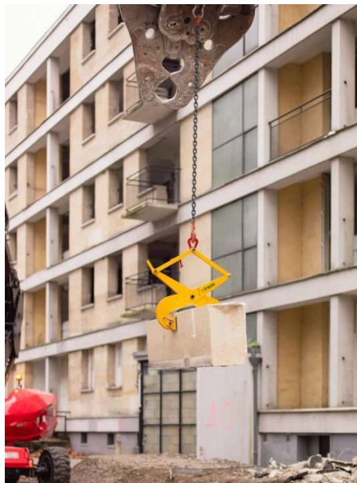
Dépose des pierres à la pince – Crédit : Bellastock
