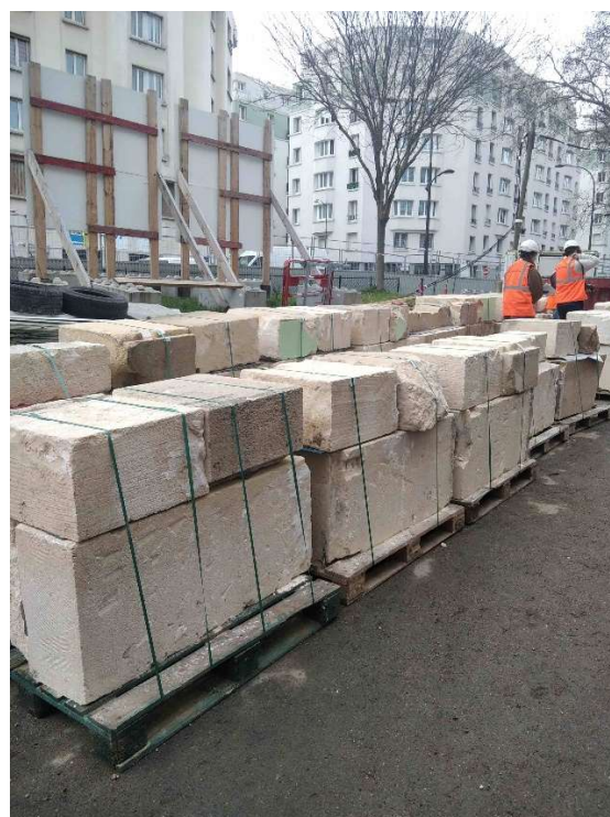
Stockage des pierres sur palette en attente de stockage sur site après dépose. Protection bande plastique au niveau du cerclage – Crédit : Ecominéro
